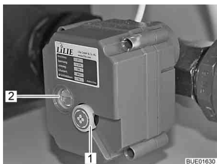
Fig. 194 Rubinetto di scarico ad azionamento elettrico
